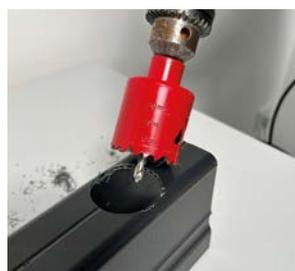
Lochsäge auf Bohrmaschine setzen und Öffnung an der Stelle schneiden, an der der Ablaufstütze platziert werden soll
