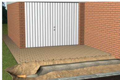
2. Streifenfundament mit C 12/C 15 ca. 30 cm breit und ca. 10 cm hoch betonieren. Anschluss beachten!
