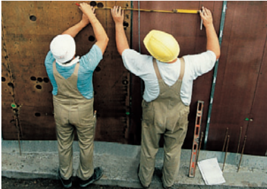
Position Leibungsfenster/Stützkreuz einmessen
