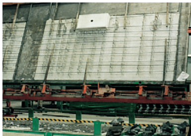
Die äußere Montageplatte verbleibt auch beim Wenden der Wand bzw. Transport sicher in der Leibung
