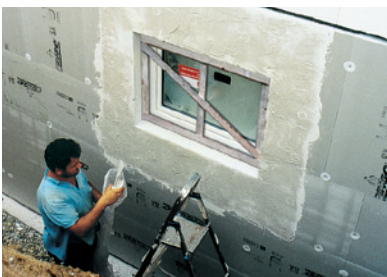
Die Stützkreuze verbleiben bis zum Abschluss der Rohbauphase zum Schutz vor Beschädigungen in dem Leibungsfenster
