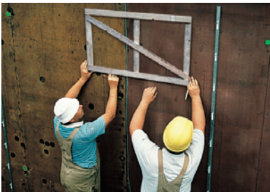
Stützkreuz auf richtiger Höhe waagrecht fixieren
