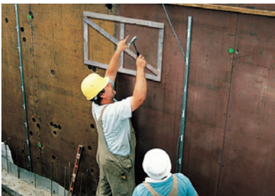
Stützkreuz auf der Schalung befestigen
