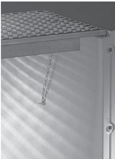
1. Lichtschachtrost einsetzen und Rostabhebesicherung einbauen.
