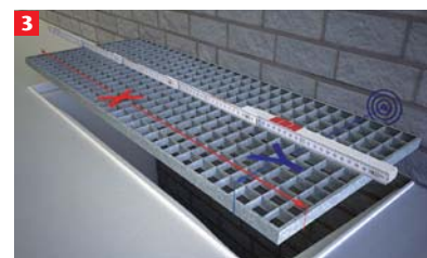
3 Ermitteln Sie die Breite des Gitterrostes (X-Maß). Ermitteln Sie die Tiefe des Gitterrostes und addieren Sie den Abstand zur Wand (Y-Maß).
