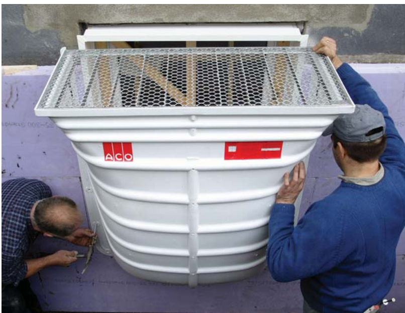
ACO Lichtschacht aus Polypropylen (PP) mit Aussteifungsrippen
