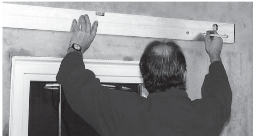
2. Die Lage des Lichtschachtes bestimmen (Oberkante Lichtschacht, Mitte Fenster) und mit der Montagehilfe für Lichtschächte die beiden obersten Löcher anzeichnen. (OK Montagehilfe = OK Lichtschacht) Den Lichtschacht anhalten und die Kontur grob mit dem Bleistift markieren.
