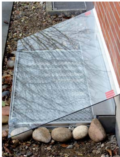
Lichtschachtabdeckung aus ESG-Glas
