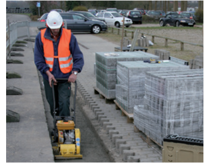
3. Einbringen des Fundamentes Verdichten des Fundamentes
