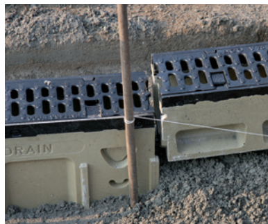
5. Anschließen der Rinnenelemente über Nut-Feder-System an den Einlaufkasten
