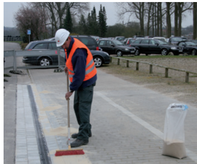
8. Verfüllen der Fugen mit Quarzsand
