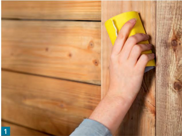
Als Vorbereitung den Arbeitsplatz mit Folie oder Papier abdecken. Lose, nicht tragfähige Altbeschichtungen entfernen. Vergraute Holzbereiche bis zum intakten Holz abschleifen.
