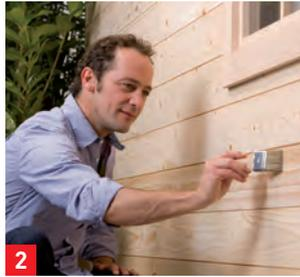
**2** Die abgeschliffene oder neue Holzoberfläche wird mit Consolan Holzgrund grundiert: Das Produkt erhöht die Haftung des Folgeanstrichs und sorgt für ein gleichmäßiges Anstrichbild.
