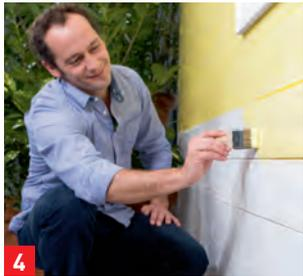
**4** Mit einem Pinsel 2 x Consolan Wetterschutz-Farbe auftragen: Die deckende, wetterfeste Farbe auf Wasserbasis ist ideal für die farbige Gestaltung von Holz im Außenbereich. Trocknungszeit: jeweils ca. 2 Stunden.
