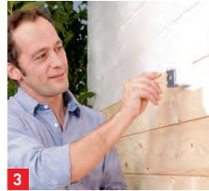
**3** Bei hellen Folgeanstrichen sollten zwei Anstriche (3 Stunden Trockenzeit zwischen den Anstrichen) mit Isoliergrund Weiss aufgetragen werden. Dies ist eine deckende Spezialgrundierung, die das Durchschlagen von Holzinhaltstoffen und die dadurch entstehenden Verfärbungen verhindert. Dann 24 Stunden nach dem letzten Anstrich mit Consolan Wetterschutz-Farbe streichen.
