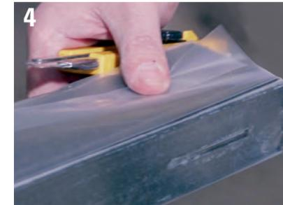
Eine optimale Haftung wird durch Andrücken des ALUJET Montape auf dem UW- bzw. CW-Profil erreicht
