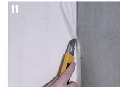
Den Trennstreifen des ALUJET Montape bündig mit z.B. einem Universalmesser abtrennen
