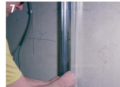
Das UW- bzw. CW-Profil lt. Herstellerangaben an Wand, Decke bzw. Boden ansetzen
