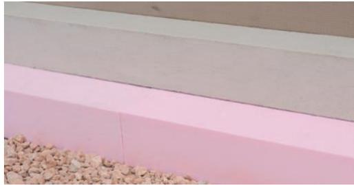
Wärmedämmplatte aus extrudiertem Polystyrolhartschaum für hohe Druckbelastungen mit **Stufenfalz (SF)**
