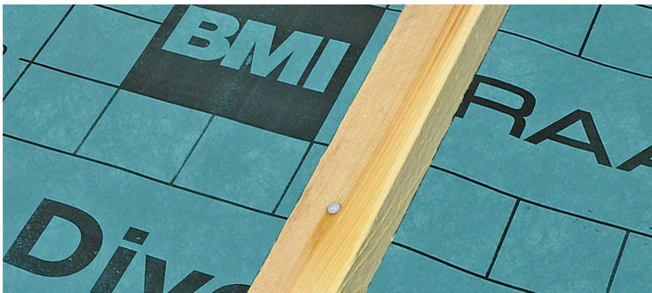
Befestigung der Konterlatte sowohl mit Nägeln als auch mit Teilgewindeschrauben möglich.
