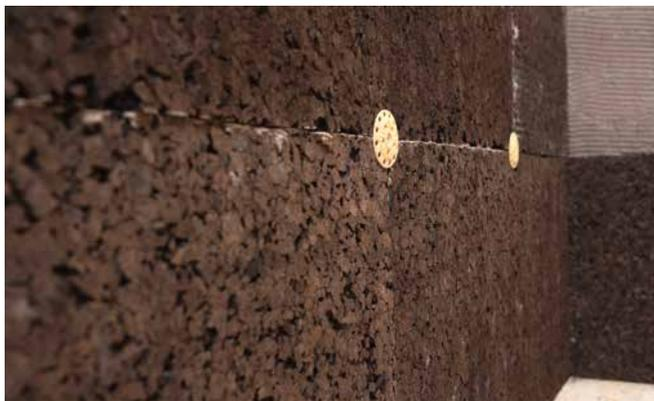
**Raumseitiger Abschluss** Die durch Cellco® Korkdämm-Platte hergestellte Dämmschicht wird raumseitig mit einer Armierungslage aus Cellco® Kork-Lehm-Klebemörtel und Gewebe versehen. Diese Lage bildet den perfekten Untergrund für Cellco® Kork-Lehm-Feinputz und einen anschließenden Lehmanstrich oder CLAYTEC YOSIMA Lehm-Designputz.
