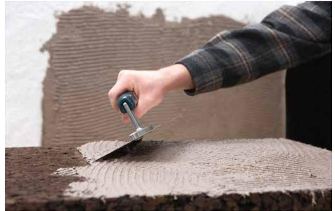
**Schritt 2:** Auftrag von Cellco® Kork-Lehm-Klebemörtel auf Cellco® Korkdämm-Platte (1 - 3 mm) um die homogene Ankopplung und die hohlraumfreie Verarbeitung zu erleichtern.
