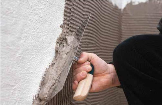
**Schritt 1:** Auftrag von Cellco® Kork-Lehm-Klebemörtel mit gezahnter Glättkelle auf die zu dämmenden Außenwandflächen. Auftragsdicken: je nach Wandbeschaffenheit 2 - 4 mm
