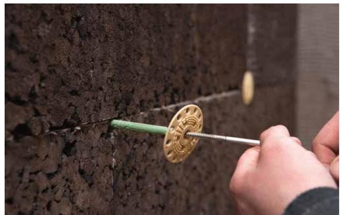
**Schritt 6:** Zusätzliche Befestigung der Cellco® EKP für einen sicheren Halt mit Tellerdübeln. Anzahl auf Bestand abstimmen. Empfehlung 4 Dübel pro m<sup>2</sup>.
