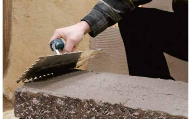
**Schritt 2:** Auftrag von Cellco® Kork-Lehm-Klebemörtel auf Cellco® Korkdämmlehm-Platte (1 - 3 mm) um die homogene Ankopplung und die hohlraumfreie Verarbeitung zu erreichen.
