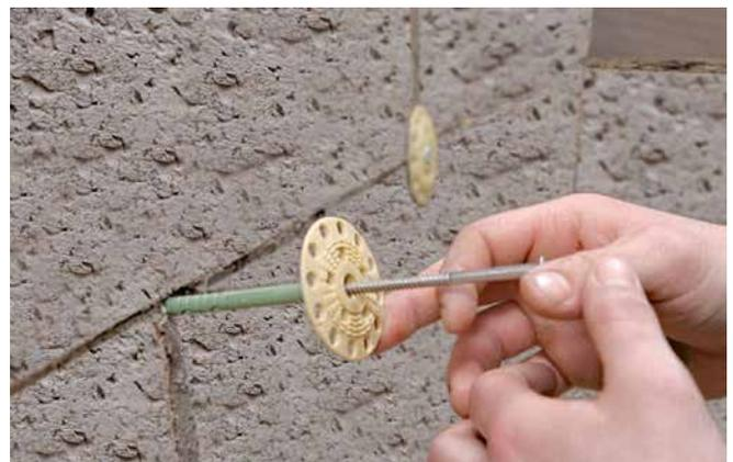
**Schritt 6:** Zusätzliche Befestigung der Cellco® KDL für einen sicheren Halt mit Tellerdübeln. Anzahl auf Bestand abgestimmt. Empfehlung 4 Tellerdübel pro m<sup>2</sup>.
