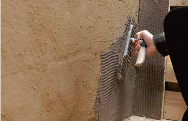
**Schritt 1:** Auftrag von Cellco® Kork-Lehm-Klebemörtel mit gezahnter Glättekelle auf die zu dämmenden Außenwandflächen. Auftragstärke: je nach Wandbeschaffenheit 2 - 4 mm.
