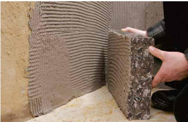
**Schritt 3:** Beim Ansetzen der Korkdämmlehm-Platte in den Cellco® Kork-Lehm-Klebemörtel ist darauf zu achten, dass keine Schmutzteile oder andere Klumpen auf der ebenen Fläche vorhanden sind.
