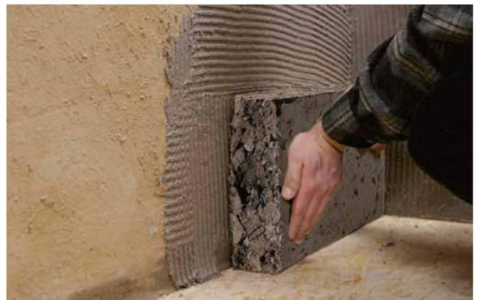
**Schritt 4:** Sattes Anreiben der Cellco® Korkdämmlehm-Platte in den Cellco® Kork-Lehm-Klebemörtel, um eine homogene Ankopplung an die Außenwand zu erreichen.
