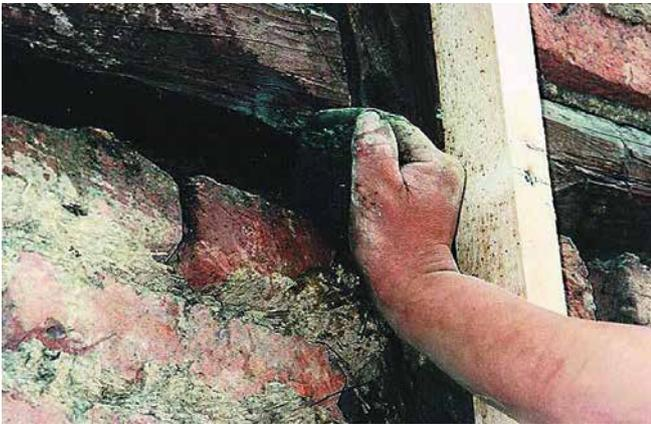
**Schritt 1:** Auskneten von größeren Löchern und Spalten mit Cellco®-Wärmedämmlehm, um Hohlraumbildung zu vermeiden.
