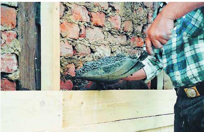
**Schritt 5:** Einfüllen von Cellco®-Wärmedämmlehm zwischen Außenwand und innerer Schalung. Einfüllhöhe auf 20cm begrenzen, um eine ausreichende Verdichtung zu ermöglichen.
