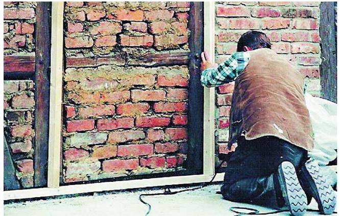
**Schritt 2:** Vertikale Holzlattung zur Vorgabe der Cellco® Dämmstärke auf das vorhandene Fachwerk aufbringen. Eine ebene Wandoberfläche kann über eine fluchtgerechte Verarbeitung erreicht werden.
