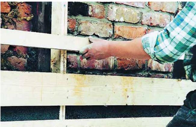
**Schritt 3:** Befestigen einer horizontalen Holz-Schalung auf der vertikalen Holzlattung. Zwischen den Schalbrettern jeweils eine lose Latte als Abstandshalter und Stampfbegrenzung einlegen.
