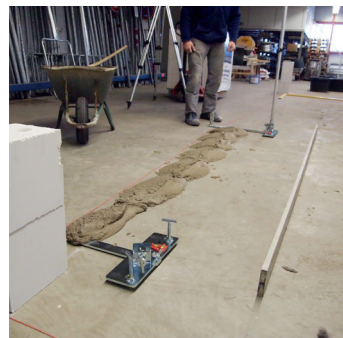
Ausnivellieren der Anlegehilfen und auflegen des Ansetzmörtels
