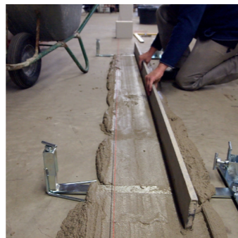
Verlängern des Mörtelbetts durch Versetzen einer Anlegehilfe
