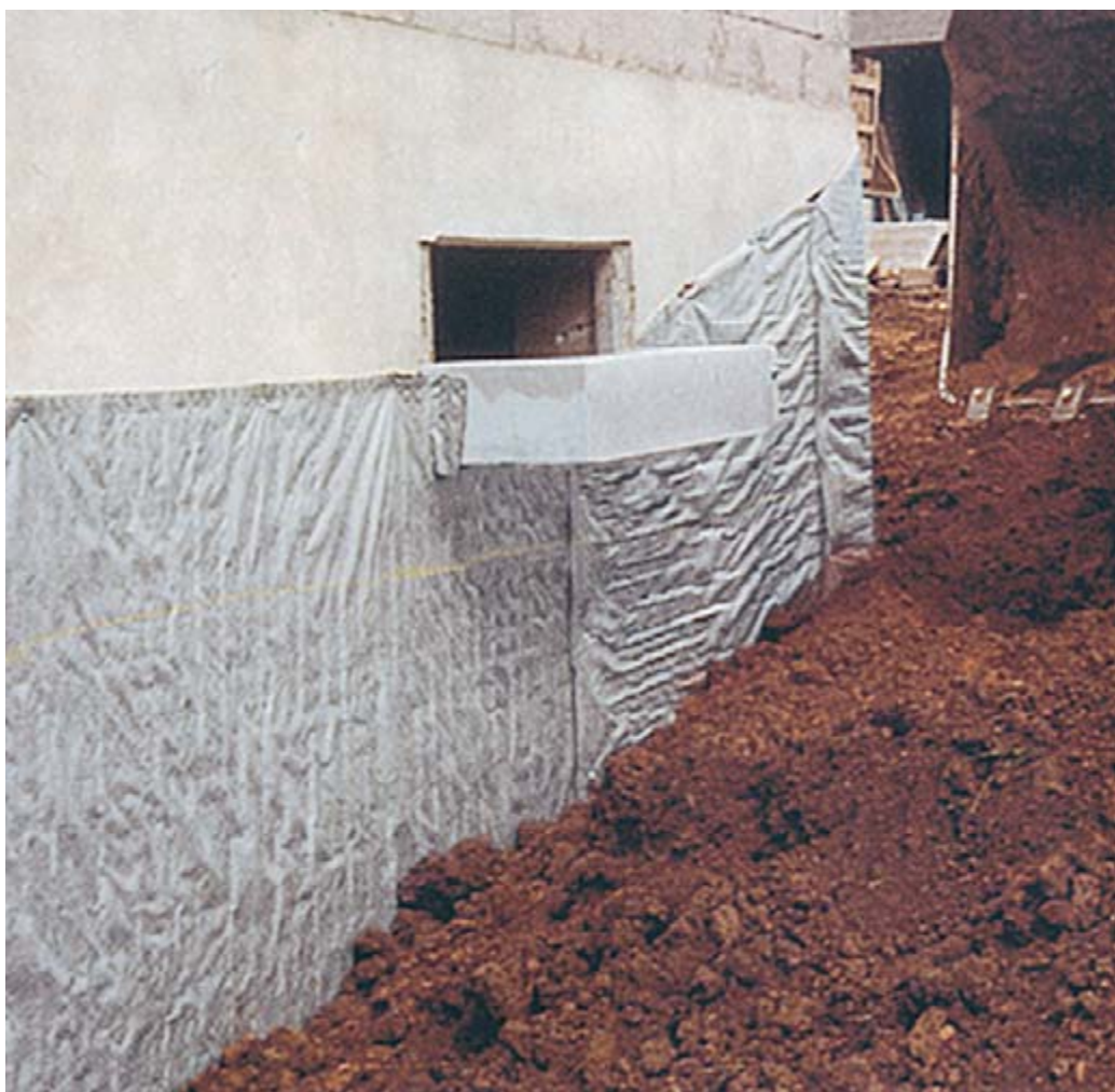
DELTA®-DRAIN hält die Grundmauer trocken und wirkt als zusätzliche Wärmedämmung.
