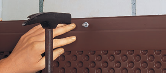
DELTA®-NOPPENBAHNEN-PROFIL als Oberkantenabschluss.
