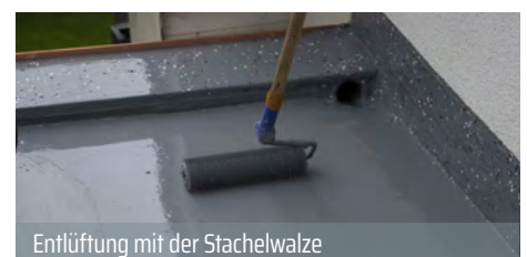
Auftrag der Beschichtung
