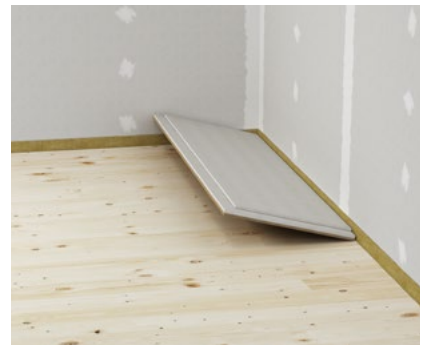
3 Verlegen der fermacell® Estrichelemente
