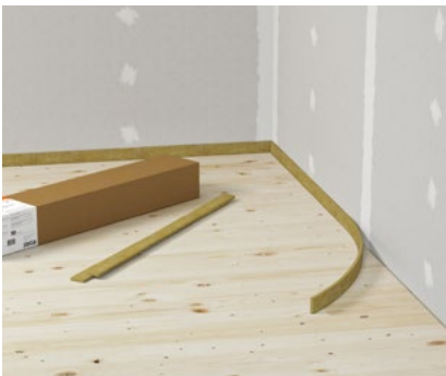
1 Randdämmstreifen verlegen und in den Ecken stumpf stoßen
