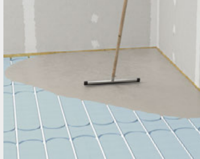
Ausgießen der Therm25-Elemente mit fermacell™ Ansetzbinder
