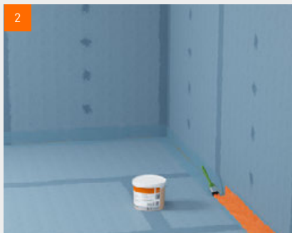
fermacell™ Flüssigfolie in der Ecke auftragen
