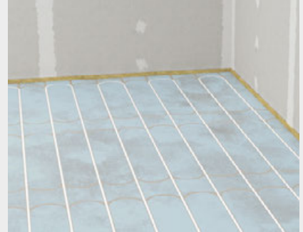
Fertig ausgegossene Therm25-Elemente (Q1)
