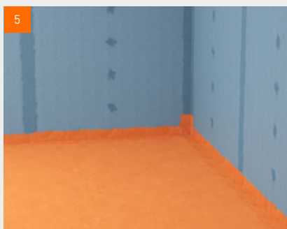
Vollflächige Abdichtung der Fläche im Bereich W1-I
