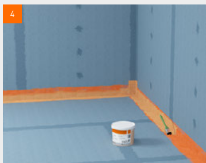
Dichtband direkt nach dem Eindrücken mit fermacell™ Flüssigfolie überstreichen
