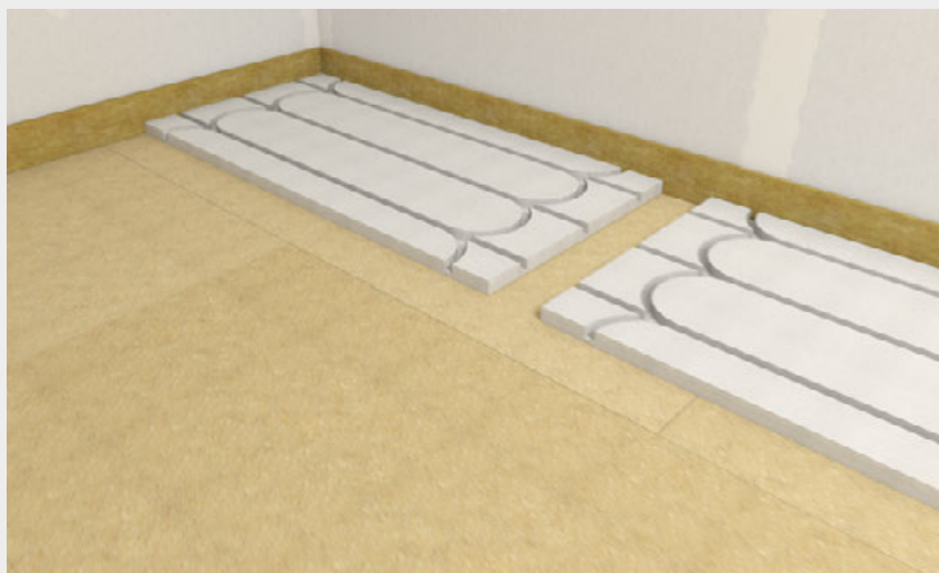
Verlegung der fermacell® Therm25-Elemente (Variante 1) lose verlegt, stumpf gestoßen im Kreuzverbund
