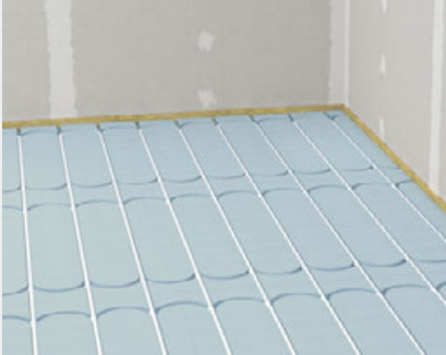
Einlegen der 16 mm Fußbodenheizrohre
