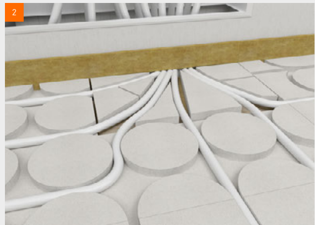
Offen lassen und mit Füllstücken aus fermacell® Gipsfaser-Platten ergänzen
