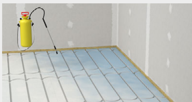
Grundieren der fermacell® Therm25-Elemente mit fermacell™ Tiefengrund
