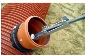
5. Das Werkzeug durch den Stutzen bis in das Hauptrohr einführen und um 180° drehen, bis der Ausleger kippt.
