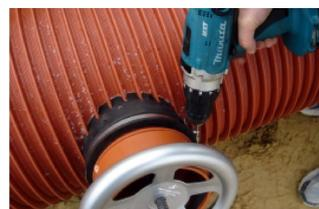
8. Vor Entfernen des Werkzeuges das Spannband mit 8Nm anziehen.
