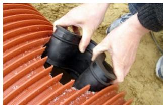
2. Insitu Dichtung im Bohrloch platzieren.
