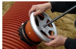
7. Durch Drehen des Rades das Werkzeug einspannen. Das Rohr gleitet gegen die Stopp-Kante.
