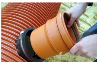
4. Das Rohr in die Insitu Dichtung einführen.
