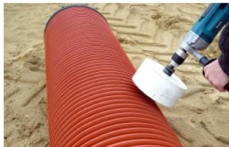
1. Die Bohrung in der angegebenen Größe herstellen und das Bohrloch entgraten.
