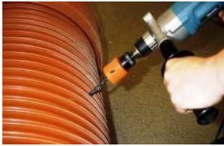
Die Kernbohrung mit einer geeigneter Bohrkronen oder Lochsäge in dem geforderten Durchmesser herstellen.
