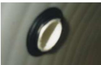
Achten Sie darauf, dass das anzuschließende Rohr nicht in das Hauptrohr hineinragt.
