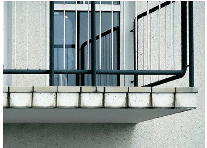
Schmutzfahnen sind unvermeidbar, wenn Oberflächenwasser unkontrolliert an der Stirnseite der Balkonkragplatte abläuft. Diese unansehnliche Ausführung ist im Mehrgeschosswohnbereich nach DIN 1986-100 unzulässig.
