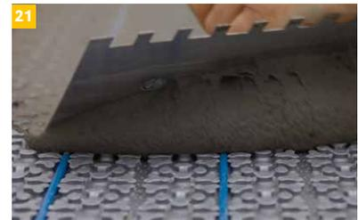
... oder es erfolgt die Belagsverklebung „Frisch-in-Frisch“. Hierzu wird IndorTec® THERM-E Zug um Zug mit Klebemörtel ausgespachtelt.
