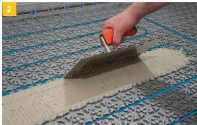
Der Dichtkleber wird nach Herstellerangabe auf die Stoßbereiche von IndorTec® THERM-E bzw. an die Anschlussbereiche angrenzender Bauteile aufgebracht.
