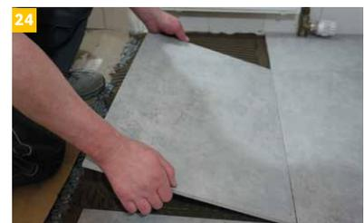
Die Klebemörtelstärke zwischen Oberkante IndorTec® THERM-E und Fliesenunterseite darf 5 mm nicht übersteigen. Mit schwundkompensierten Mittelbettklebemörteln sind Kleberbettstärken bis 10 mm möglich.
