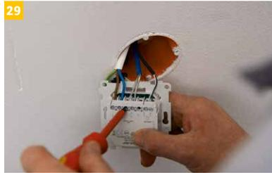
Der Anschluss des Heizkabels und des Bodenfühlers an das Thermostat erfolgt durch eine Elektrofachkraft. Für die Thermostate IndorTec® THERM-E bestehen eigenständige Montage- und Bedienungs-/ Programmierungshinweise, diese sind den Verpackungen beigelegt bzw. stehen als Download auf den Produktseiten im Internet zur Verfügung.
