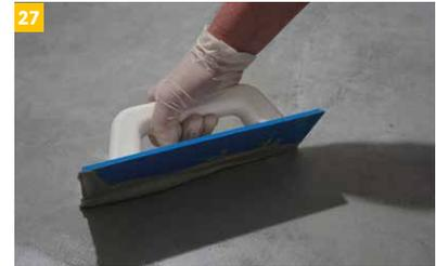
Die Belagsverfugung erfolgt nach Begehrbarkeit der Belagsfläche. Aufgrund der fehlenden Saugfähigkeit von Kunststoffmatten ist mit einer 3- bis 4-fach längeren Erhärtungszeit des Klebers gegenüber saugfähigen Untergründen zu rechnen.
