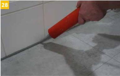
Ausbildung von Anschluss- und Bewegungsfugen mit geeigneten weichen Fugenfüllstoffen.
