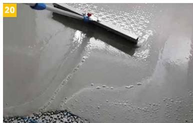
Nach Erhärtung der THERM-E Verklebung kann alternativ eine fließfähige Bodenspachtelmasse mit einer Mindestüberdeckung von 3 mm eingebracht werden ...
