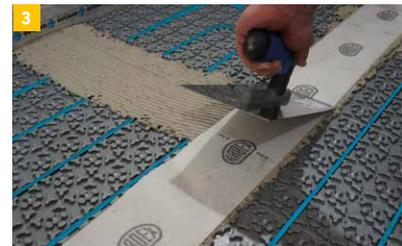
Entsprechende System-Dichtelemente (Dichtbänder, Dichtbändecken, -manschetten etc.) werden frisch in den Dichtkleber eingebettet und überarbeitet.
