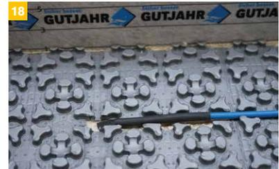
Für das Ende des Warmleiters schneidet man der Länge nach eine Kerbe in die Matte. **Wichtig: Ein Kürzen des Warmleiters ist unzulässig und führt zur Beschädigung des Systems!**
