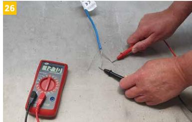
Nach Abschluss der Belagsverlegung ist erneut der Gesamtwiderstand des Heizkabels gemäß Abnahmeprotokoll zu überprüfen und zu protokollieren.
