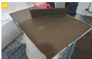
Der Belag wird vollsatt in die Kleberschicht gebettet. Insbesondere bei großformatigen Fliesen ist eine Verlegung im kombinierten Verfahren zweckmäßig.
