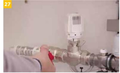
Funktionsheizen und anschließend den hydraulischen Abgleich durchführen entsprechend den Auslegungsberechnungen. (siehe Seite 6)
