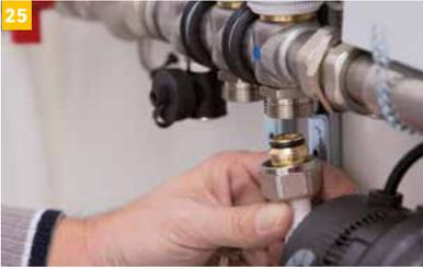
Die Klemmringverschraubung (Lieferbestandteil) über das vorher abgelängte Rohr schieben und mit einem nach vorne offenen Ringschlüssel an den Heizkreisverteiler anschliessen. Alle Rohrverbindungen sind frei von Zug-, Druck- und Drehbelastungen zu montieren.
