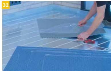
Zur Verlegung der selbstklebenden IndorTec® THERM-W Entkopplungsmatte wird die rückseitige Schutzfolie zu etwa einem Viertel entfernt und die Matte auf die gereinigten Systemelemente ausgerichtet. Danach wird die restliche Folie abgezogen und die Entkopplungsmatte vollflächig verklebt.
