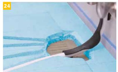
24 Die Heizrohrbögen sind grundsätzlich mit den System-Winkelrohrspannen (Lieferbestandteil) auszuführen. Diese gewährleisten die Einhaltung des Biegeradius, schützen die Rohre und erleichtern den Anschluss des Rohres an den Verteiler. Ein Biegeradius von 8 cm ist nicht zu unterschreiten.
