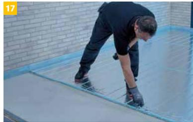
17 Nach Aushärtung des Klebemörtels können die Heizrohre in die Heizelemente verlegt werden. Dazu werden die benötigten Rohrführungen mit einem Cutter-Messer eingeschnitten.
