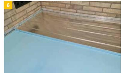
6 Bei Wohnungstrenndecken gegen unbeheizte Räume oder Rohbetondecke auf Erdreich kann das IndorTec® THERM-W Füllelement als Zusatzdämmung eingesetzt werden. Dabei werden die Elemente mit geeignetem Klebemörtel miteinander verklebt.
