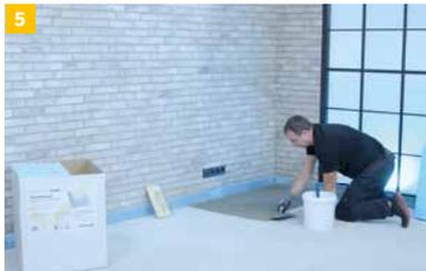
5 Klebemörtel zur Verlegung der IndorTec® THERM-W Flächenelemente auf den Untergrund mit geeigneter Zahnkelle (z. B. 8 mm) auftragen. Schnell erhärtende Klebemörtel verkürzen die Trocknungszeit.
