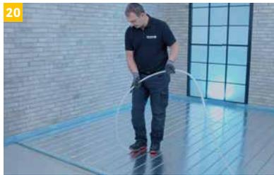
20 Das auf das System abgestimmte Heizrohr vom Verteiler aus beginnend in die speziell geformte Ω-Führung der IndorTec® THERM-W Heizelemente einbringen.
