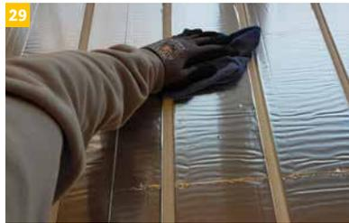
Vor Verlegung der IndorTec® THERM-W Entkopplungsmatte sind die Systemelemente von Staub und Schmutz zu reinigen. Laufwege sind bei den Nachfolgearbeiten entsprechend mit geeigneten Materialien abzudecken.
