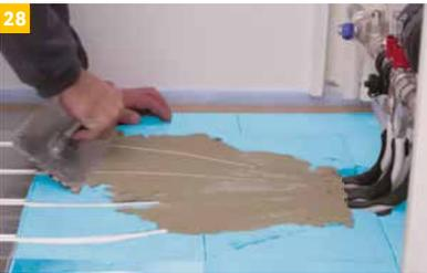
Dann erfolgt das oberflächenbündige Ausspachteln der Anschlussplatte mit geeignetem Klebemörtel.
