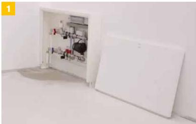
1 Verteilerschrank auf Höhe einstellen und Estrichblende entfernen
