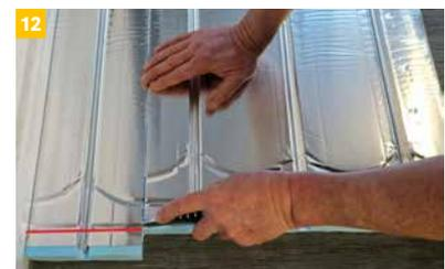
12 Anschließend wird der 15 cm Abschnitt in der Länge um 3,75 cm gekürzt (Mitte der Rohrführung)...
