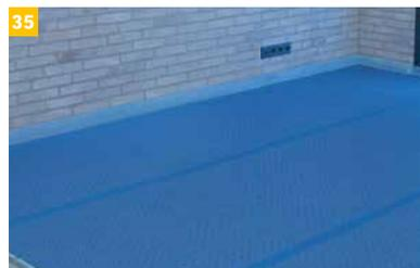
Die Mattenstöße sind so zu überlappen, dass kein Dünnbettmörtel in den Stoßbereichen durchtreten kann.
