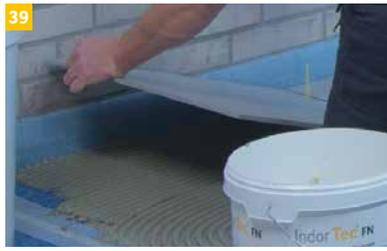
Bei Großformaten sollte die Kontaktpachtelung mit einer rückseitigen Aufzahnung ergänzt werden, um eine satte Verlegung und ein gewisses Ausgleichspotential zu erreichen.
