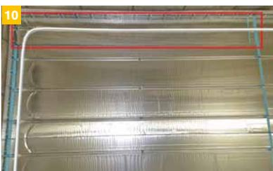
10 Um die Anbindeleitung /Vorlauf in die Rohrführung der Heizplatte zu führen, wird die entsprechende Umlenkung angepasst.
