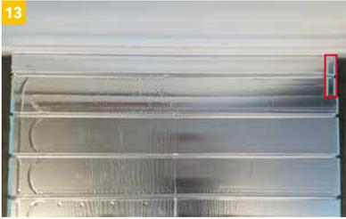
13 ...und auf der gegenüberliegenden Seite wieder eingelegt. Somit entsteht eine einfache Rohrführung der Anbindeleitung zum Heizkreis.
