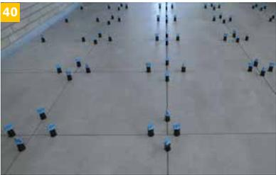
Um eine planebene Verlegung der Fliesen und Platten zu erzielen, empfehlen wir die Verwendung des IndorTec® FN Fliesenleveliersystems.
