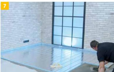
7 Anschließend folgt die Verlegung der IndorTec® THERM-W Flächenelemente nach freien Vorgaben oder nach den Vorgaben des Verlegeplanes.
