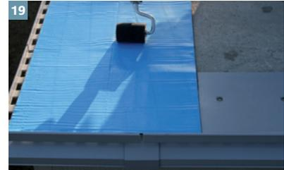
Nach dem vollständigen Aufkleben wird das komplette DiProtec® KSK-AB Abdichtungsband mit einer Andruckrolle vollständig überarbeitet. Die weiteren DiProtec® KSK-AB Abdichtungsbänder wie...
