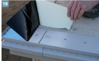
Jetzt die hintere Hälfte umklappen, Silikonpapier abziehen und DiProtec® KSK-AB Abdichtungsband blasenfrei ankleben.
