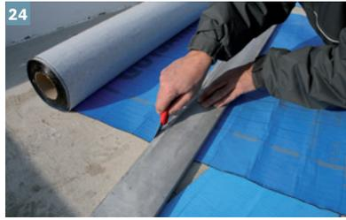
24 Nach Eindichtung der Randprofile mit der Flächenabdichtung beginnen. Anschließend die DiProtec® KSK Bahnen auslegen und passend zuschneiden.
