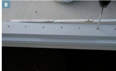
Die Eckteile in beiden Lochungen befestigen, die Profilstangen mit einem maximalen Abstand = 5 Lochungen. Nach jeder Bohrung den Dübel setzen, das sichert die Profilstangen vor Verschiebung.
