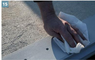
Unmittelbar vor dem Aufkleben der DiProtec® KSK-AB Abdichtungsbänder sind die Profiloberflächen von Staub und Fett zu reinigen.
