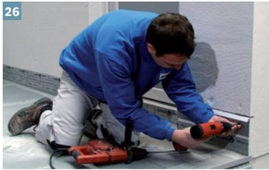
26 Dann wird das Profil eingeschoben und im Untergrund verdübelt. Die Profilnase stellt sicher, dass Fassadenwasser die Abdichtung nicht hinterlaufen kann.
