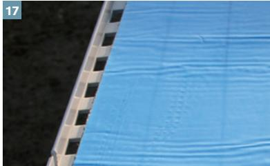
Direkt an den Drainlochstanzen der Abschlussprofile ansetzen.
