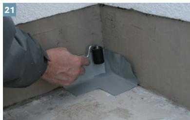
Die Ausführung der Ecken erfolgt mit den selbstklebenden Fertigecken DiProtec® AB-K Innenecke bzw. Außenecke. Diese werden vor der Verklebung der Flächenbahn verlegt.
