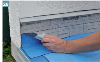
28 Zur Erstellung eines normgerechten Boden-/Wandanschlusses (welcher auch verputzbar bzw. verfliesbar ist) mit einer mind. 15 cm hoch geführten ...
