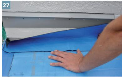
27 In einem letzten Arbeitsschritt wird das KSK-AB Abdichtungsband auf das Sockelprofil aufgeklebt. Auch hier ist auf eine 10 cm Überlappung auf der DiProtec® KSK Bahn zu achten.
