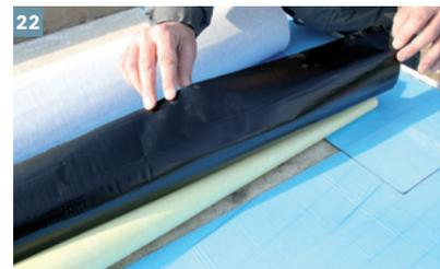
Bahn umschlagen, Silikonpapier abziehen und DiProtec® KSK Bahn ausrichten. Ca. zur Hälfte umschlagen/klappen und unter gleichmäßigen Druck auflegen. Bahnen blasenfrei verkleben.
