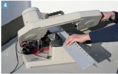
Die Profilstangen mit ca. 2 – 5 mm Bewegungsfuge zu benachbarten Profilen mittels Hand oder Bandsäge einmessen und ablängen.
