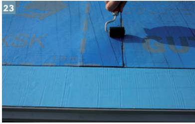
23 Entsprechend den Regelwerken sind auch bei KSK-Bahnen die Verklebungen mit mindestens 10 cm Überlappung auszuführen.
