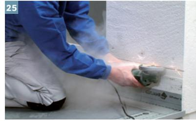
25 Der Boden-Wandanschluss erfolgt mit dem ProFin® SP Sockelprofil. Hierfür wird zunächst die Wand eingeschnitten.
