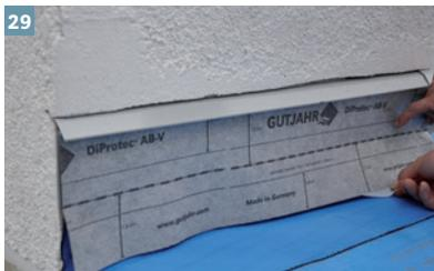
29 ... Abdichtung wird das selbstklebende Abdichtungsband DiProtec® AB-V (oberseitig vlieskaschiert) auf der Wand verklebt.
