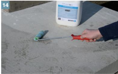
Grundierung der abzudichtenden Flächen, Boden und Sockelbereich mit DiProtec® PR-ZE. Die Folgearbeiten erst nach ca. 2 Std. Abluftzeit beginnen (Fingerprobe).
