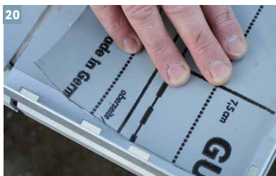
20 Vordere Hälfte zum Teil abziehen und unmittelbar an den Drainlochstanzen der Abschlussprofile ansetzen.
