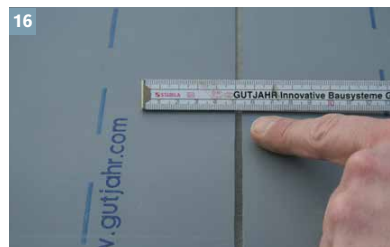
16 Die Hilfslinienmarkierung gibt die Ansätze der DiProtec® AB-K Abdichtungsbänder vor. Mindestaufklebeflächen von 5 cm je Seite sind einzuhalten.
