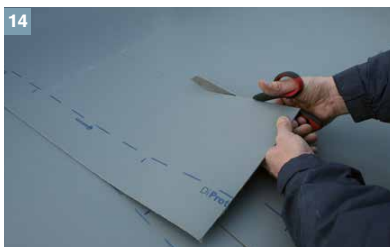
14 Die DiProtec® SDB auslegen und mit ca. 3 – 5 mm Abstand einmessen und zuschneiden.
