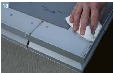
18 Unmittelbar vor dem Aufkleben der DiProtec® AB-K Abdichtungsbänder müssen die Profiloberflächen trocken, staub- und fettfrei sein.
