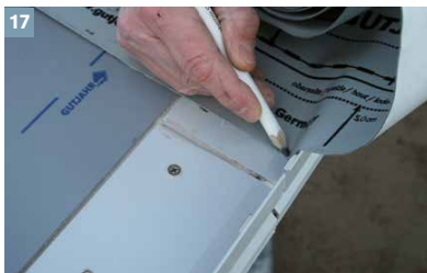
17 Nach dem Auslegen der DiProtec® SDB erfolgt der Zuschnitt der DiProtec® AB-K Abdichtungsbänder.
