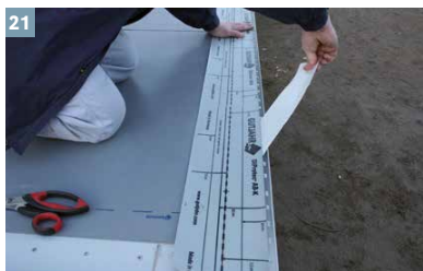
21 Zug um Zug die vordere Hälfte der Silikonfolie abziehen und das DiProtec® AB-K Abdichtungsband blasenfrei andrücken.
