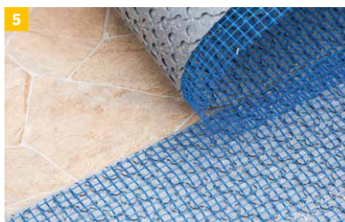
5 Die Matten werden stumpf aneinander gestoßen wobei das überstehende Gittergewebe auf die benachbarten Matten überlappt.
