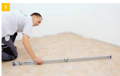
1 Prüfung des Untergrundes auf Eignung und Ebenflächigkeit. Ggfls. sind Ausgleichsarbeiten durchzuführen.
