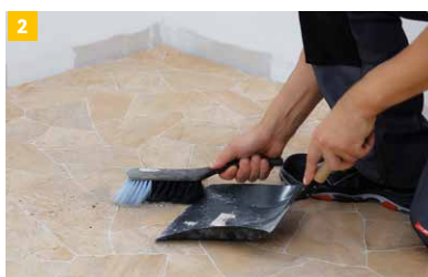
2 Säubern des Untergrundes. Ein Grundieren kann entfallen.
