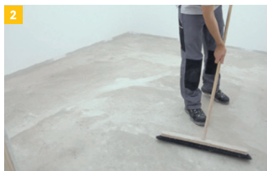
2 Säubern und Grundieren des Untergrundes.
