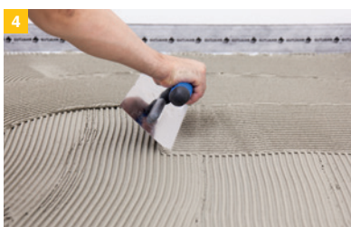
4 Klebemörtel, abgestimmt auf den Untergrund, mit einer 6 mm Zahnkelle auftragen und...
