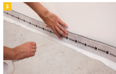
3 Entlang aufgehender Bauteile und Belagsdurchdringungen ist der AquaDrain® RD Randdämmstreifen „zu stellen.
