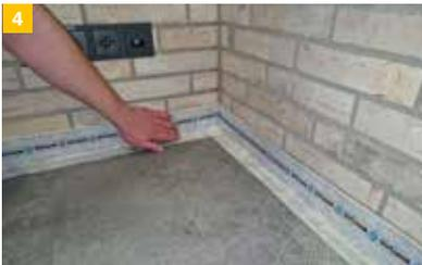
4 Vor Verlegung der IndorTec® THERM-W Flächenelemente ist zu angrenzenden Bauteilen und Belagsdurchdringungen der AquaDrain® RD Randdämmstreifen zu verlegen.
