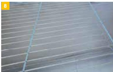
8 Die Flächenelemente sind dicht an dicht zu stoßen und in einer Ebene zu verlegen. Die Rohrführungen der Elemente sind stets in einer Flucht auszuführen.
