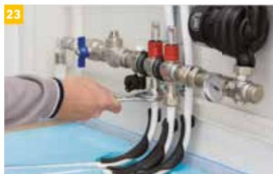
23 Das Heizrohr von einer Seite beginnend an den Verteiler anschließen. Die außen verlaufenden Heizrohre immer am oberen Verteilerbalken anschließen, um Kreuzungen zu vermeiden.
