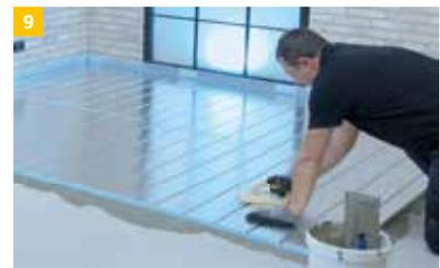
9 Um eine gute Haftung zum Untergrund zu gewährleisten, werden die Elemente flächig in den frischen Klebemörtel angedrückt. Es ist darauf zu achten dass Folgearbeiten erst nach ausreichender Erhärtung der vorherigen Verklebung erfolgen.
