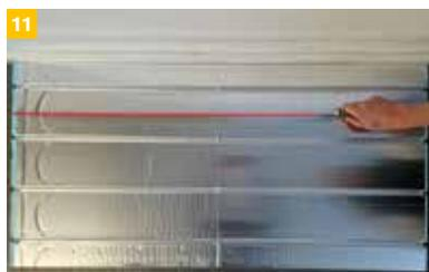
11 Hierfür wird das Heizelement in der Breite um 15 cm gekürzt.
