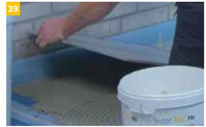
Bei Großformaten sollte die Kontaktpachtelung mit einer rückseitigen Aufzahnung ergänzt werden, um eine satte Verlegung und ein gewisses Ausgleichspotential zu erreichen.
