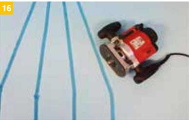
16 Alternativ können zusätzliche Rohrführungen auch mit einer Oberfräse und einem 19 mm Hohlkehlfräser erstellt werden.
