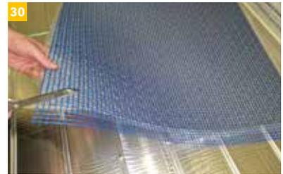
Bei der ersten Matte wird das überstehende Gewebe an der kurzen Seite abgetrennt und dann mit der abgetrennten Seite an die Randdämmstreifen angrenzend, verlegt.
