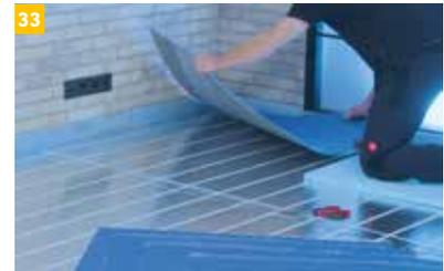
Bitte beachten Sie, dass die Matten passend gelegt werden müssen und sich nach dem Andrücken nicht wiederaufnehmen lassen ohne dass es zu einer Beschädigung der Flächenelemente kommt. Begonnen wird mit der Verlegung in der von der Tür am weitesten entfernten rechten Ecke des Raumes.
