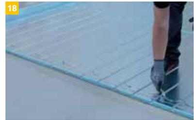
18 Tipp: Bei den Umlenkbögen muss nur jede zweite Umlenkung eingeschnitten werden.
