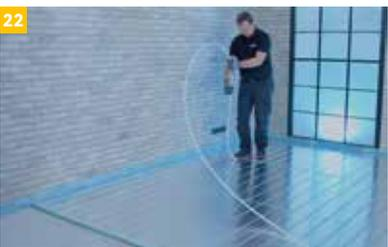
22 Um ein Verdrehen des Heizrohres zu verhindern, wird empfohlen einen Abstand von 3-4 m zwischen Rohrhaspel bzw. Heizrohrrolle und zu verlegender Heizfläche einzuhalten.
