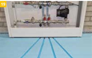
19 Vor dem Verteiler wird zur sauberen Rohrführung der Heizkreise i.d.R ein IndorTec® THERM-W Füllelement eingesetzt. Die Rohrführung zum Verteiler kann mit einer Oberfräse und einem 19 mm Hohlkehlfräser, oder mit einem Heißschneidegerät in das Füllelement eingearbeitet werden.
