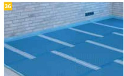
Die langen Stöße der IndorTec® THERM-W Entkopplungsmatte wird mit der selbstklebenden Watec® ST Stoßarmierung abgeklebt.
