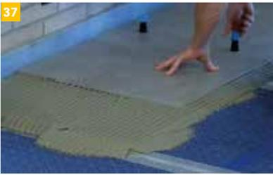
Jetzt wird die Entkopplungsmatte Zug um Zug abgespachtelt und dann das Dünnbett direkt mit geeigneter Zahnung aufgezahnt. Die Klebemörtelstärke zwischen IndorTec® THERM-W Entkopplungsmatte und Unterkante Fliese sollte mind. 3 mm betragen.
