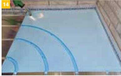
14 Zum Schneiden von individuellen Rohrführungen wird die Verwendung eines Heißschneidegerätes empfohlen. Diese können durch leichtes Ziehen oder Schieben des Gerätes durch das Material erstellt werden.
