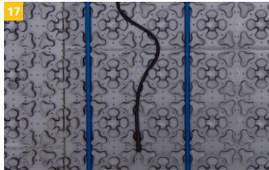
Einlegen des Bodenfühlers zwischen zwei Warmleitern des Heizkabels.
