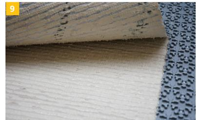
9 Somit wird eine vollflächige Einbettung zum Untergrund erreicht. Weiterführende Arbeiten erfolgen nach Erhärtung der Verklebung von IndorTec® THERM-E.
