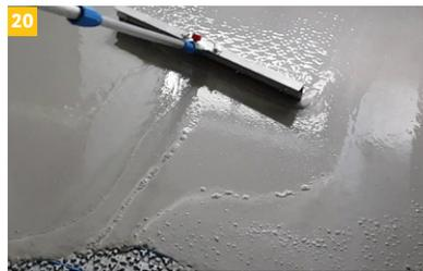
Anschließend wird die IndorTec® THERM-E Trägermatte mit einer fließfähigen Bodenspachtelmasse mit einer Mindestüberdeckung von 5 mm verspachtelt.
