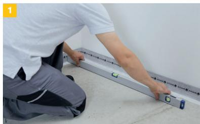
1 Prüfung des Untergrundes auf Eignung und Ebenflächigkeit. Gegebenenfalls sind Ausgleichsarbeiten durchzuführen.
