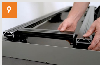
Die auf das Achsmaß zugeschnittenen Streben zwischen den Schienen einsetzen und in die Terrassenlager einklicken.
