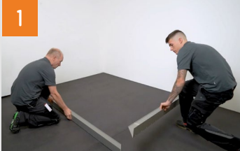
Die zugeschnittenen Unterteile der Seitenverblendung werden für den späteren seitlichen Abschluss ausgelegt, eingemessen und ausgerichtet. Das Unterteil der Seitenverblendung muss vollflächig aufliegen.
