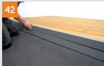
Fertigstellung der Seitenverblendung
