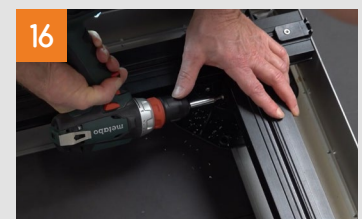
Die Schienen und Querstreben am Terrassenlager seitlich mit der Bohrschraube 3,9 x 19 mm verschrauben.
