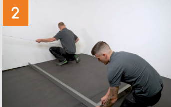
Die zugeschnittenen Unterteile der Seitenverblendung werden für den späteren seitlichen Abschluss ausgelegt, eingemessen und ausgerichtet. Das Unterteil der Seitenverblendung muss vollflächig aufliegen.
