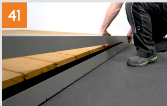
Fertigstellung der Seitenverblendung
