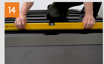
Ausrichtung der Schienen in Längs- und Querrichtung überprüfen.
