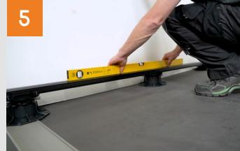
Ausrichten der Schienen durch Einstellen der Terrassenlager. Mit den Terrassenlagern kann ein Gefälle von bis zu 8 % ausgeglichen werden.
