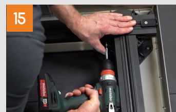
Die Schienen und Querstreben am Terrassenlager seitlich mit der Bohrschraube 3,9 x 19 mm verschrauben.
