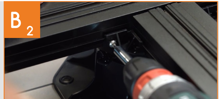
Unterkonstruktion ausrichten und mit Lagern verschrauben
