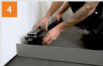
Terrassenlager entsprechend der Planung aufstellen. Dabei richten sich die Abstände der Lager nach der statischen Belastbarkeit der Schiene. Danach die Schiene auf die Terrassenlager klicken.
