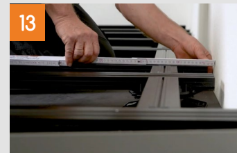
Unterkonstruktion ausrichten und mit Lagern verschrauben
