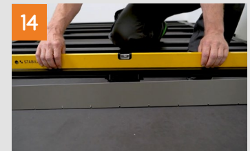
Unterkonstruktion ausrichten und mit Lagern verschrauben
