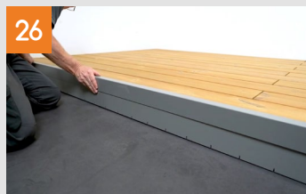
Fertigstellung der Seitenverblendung
