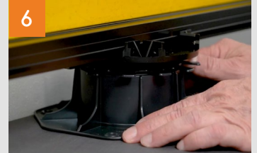
Schienen auf Terrassenlager klicken und ausrichten
