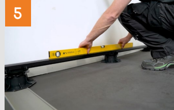
Schienen auf Terrassenlager klicken und ausrichten
