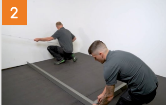
Seitenverblendung und Terrassenlager auslegen und Schienen einklicken
