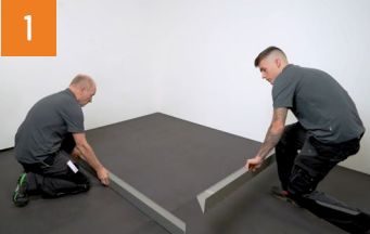
Seitenverblendung und Terrassenlager auslegen und Schienen einklicken
