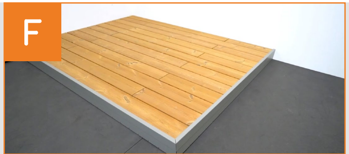
Seitenverblendung fertigstellen
