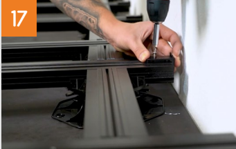
Montieren der ersten Diele
