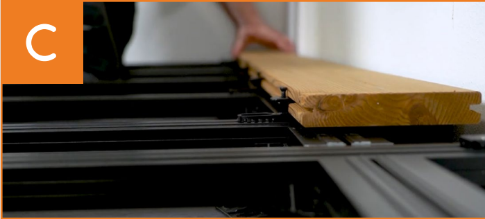
Montieren der ersten Diele
