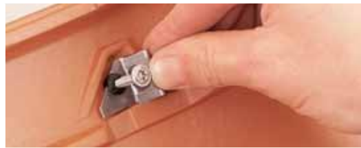
SturmFIX in die Vertiefung des Ziegels einsetzen.
