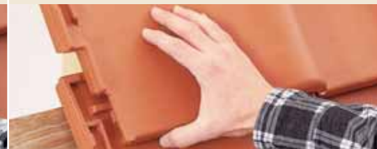
Ziegel im Fußbereich andrücken. Fertig!
