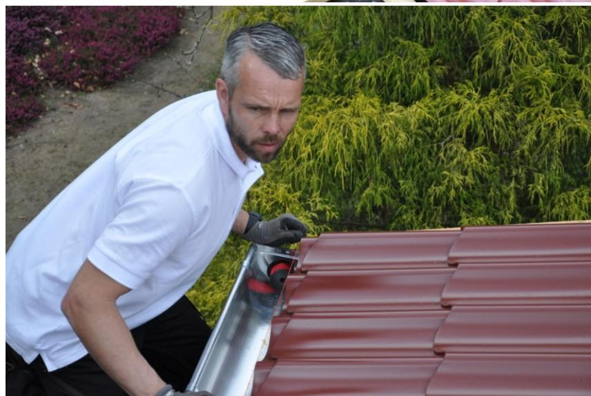
LM D-TILE immer parallel zur Traufe verlegen, die ersten Platten nicht sofort komplett verschrauben. Die Platten sollen an der Traufe leicht überstehen, sodass die Tropfkante luftumspült bleibt.
