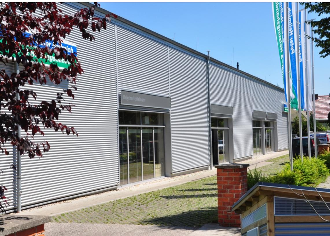
Mit unserem Wellprofil LM D-18/76 werden meist Fassaden verkleidet. Aufgrund der eingearbeiteten Antikapillarrille eignet es sich aber auch als Dachprofil.
