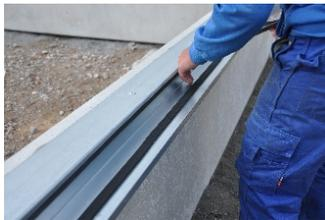
Zusätzliche Dichtstreifen sind nur zwischen Paneel und Unterkonstruktion erforderlich. Unsere Paneele sind verbaufertig. Eine Besonderheit der ROMA-Wandpaneele ab Kerndicke 60 mm besteht darin, dass sie als einzige Paneele am Markt nach der Produktion „gefräst“ werden und somit die sog. Schlösser, also die Nut-Feder-Verbindung, eine bestmögliche und einfache Montage ermöglichen. Das spart jede Menge Zeit bei der Montage und somit bares Geld!
