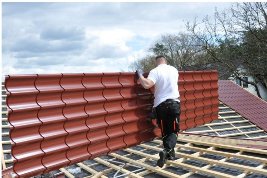
Solch eine 5 m lange Aluminiumdachpfannenplatte (= 5,30 m<sup>2</sup>) wiegt nur ca. 13 kg, in der Stahlvariante nur ca. 28 kg. Die Platten auf der Baustelle möglichst ohne große Durchbiegung transportieren!
