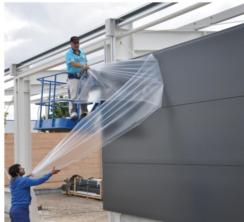
Achten Sie immer darauf, dass Schutzfolien gleich nach der Montage entfernt werden. Das gilt auch für Späne!
