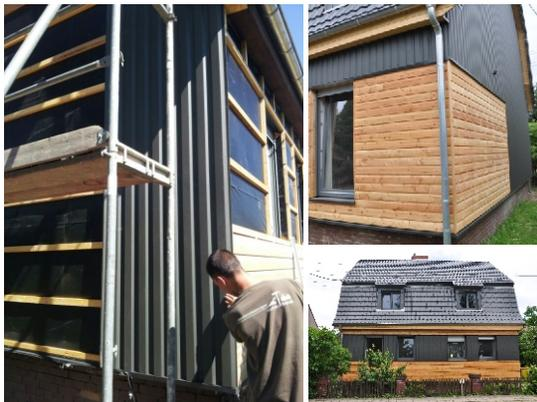
Die Befestigung der Profiltafeln erfolgte mit lackierten Edelstahl-Bohrschrauben. Kanteile, wie Fensterlaibungen und Tropfkanten, stellte der Fassadenbauer aus Flachblech selbst her, hätten aber auch bei **LUXMETALL** passgenau bestellt werden können.
