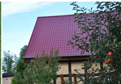
Die Verlegung der Bleche erfolgte schnell und in sehr guter Qualität. Die Verschraubung sorgt für eine hohe Sturm- und Windsogsicherheit. Die Giebelseiten erhielten, ebenso wie der First, einen Abschluss aus dem gleichen Material.
