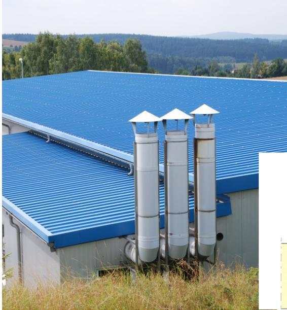
Roma-Dachpaneele werden werkseitig mit drei Dichtungen versehen. Somit können die Elemente problemlos und schnell verbaut werden. Und sind dicht. Mit Kernstärken von 30-140 mm lieferbar. Es gibt auch eine Sparvariante: das Trapez DUO 62 mit unterseitiger Aluminiumfolienkaschierung und ca. 18 mm PUR-Beschichtung.
