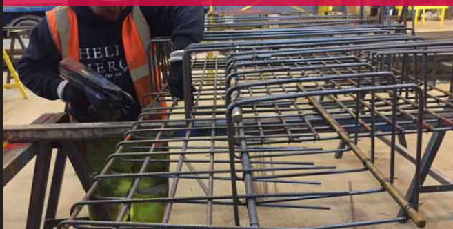
Vorfertigung im Werk
