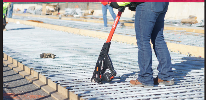
Bewehrung in Fahrbahndecken
