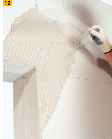
12 Armierungspfeile über Fensteröffnung
