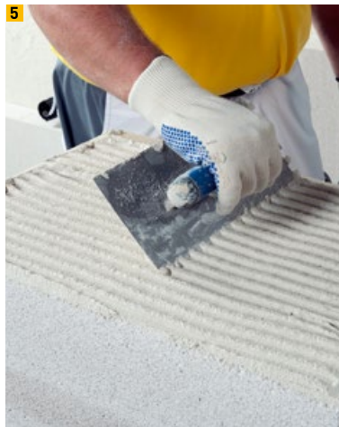
5 Multipor Leichtmörtel auf Dämmplatte auftragen
