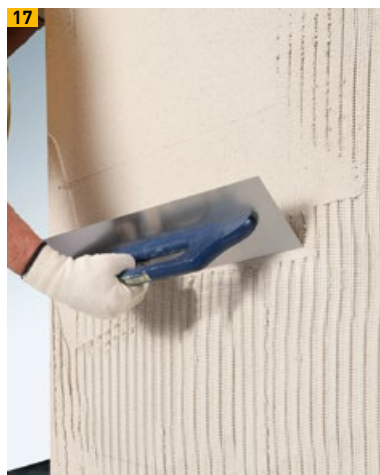
17 Armierungsgewebe einputzen
