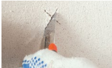
Vorsichtiges Einschlitzen der Putzschale
