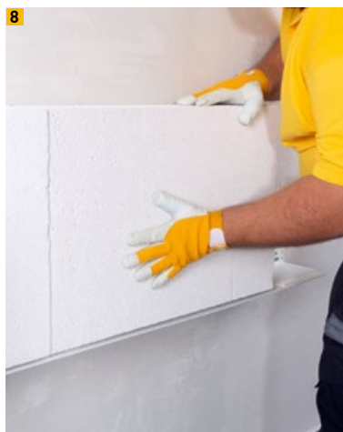
8 Multipor Mineraldämmplatte andrücken und einschwimmen
