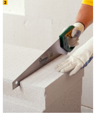
3 Schneiden der Mineraldämmplatte
