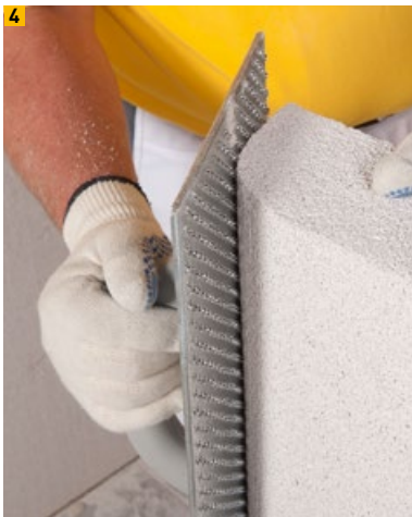
4 Anpassung der Dämmplatte
