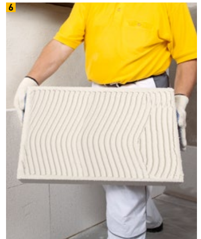
6 Vollflächig aufgetragener Mörtel
