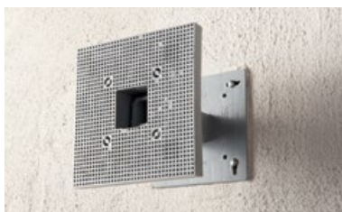
Einbau des Multipor Geräteträgers
