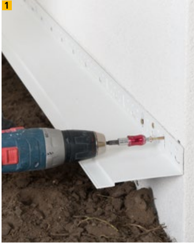
1 Kunststoffsockelschiene, gedübelt
