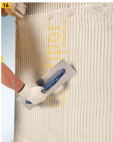
16 Armierungsgewebe einlegen
