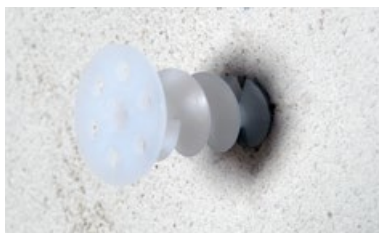
Setzen des Multipor Spiraldübel
