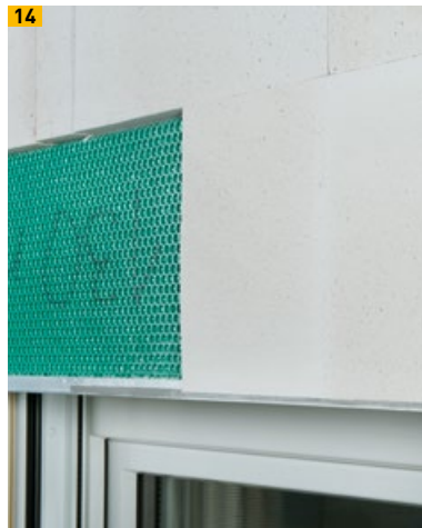
14 Überdämmung Raffstorekasten (mind. 60 mm)
