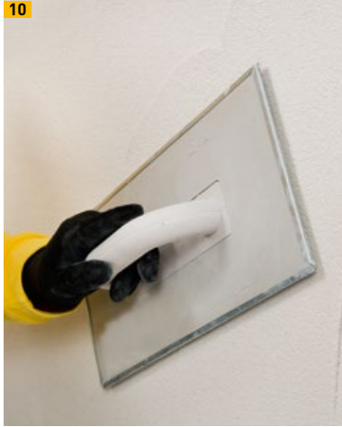
10 Beis Schleifen der Oberfläche
