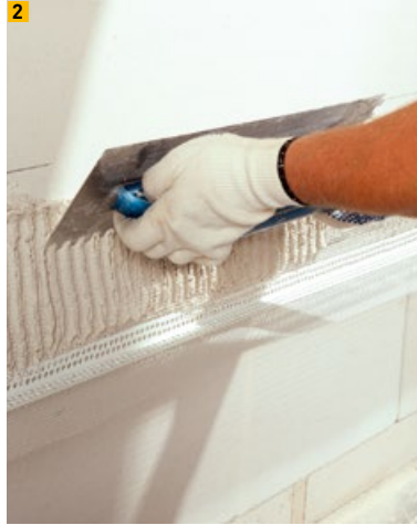
2 Sockelabschluss mit Gewebewinkel
