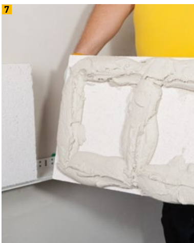
7 Randwulst-Punkt-Verklebung bei größeren Unebenheiten
