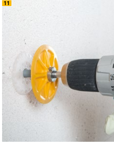
11 Dübel setzen
