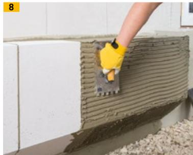
8 Für die Armierungsschicht Multipor Dichtschlämme auf die Multipor Sockeldämmplatte auftragen
