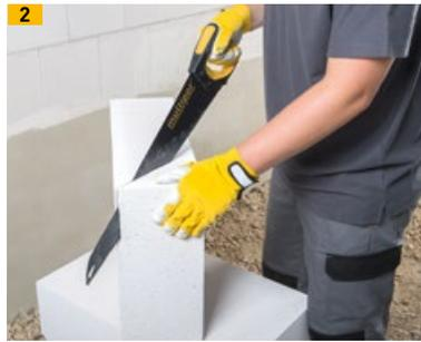
2 Multipor Sockeldämmplatte schräg zuschneiden
