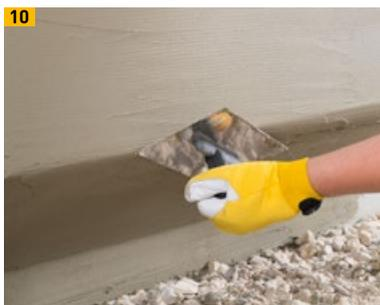
10 Armierungsschicht abziehen und 24 Stunden trocknen lassen
