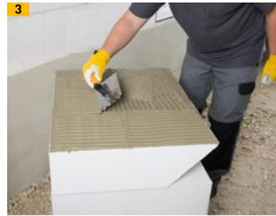
3 Multipor Dichtschlämme mit 12er-Zahntraufel vollflächig auftragen
