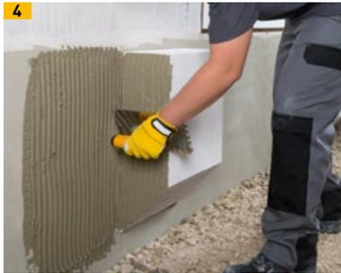
4 Stoß- und ggf. Lagerfugen mit Multipor Dichtschlämme 4 mm dick beschichten
