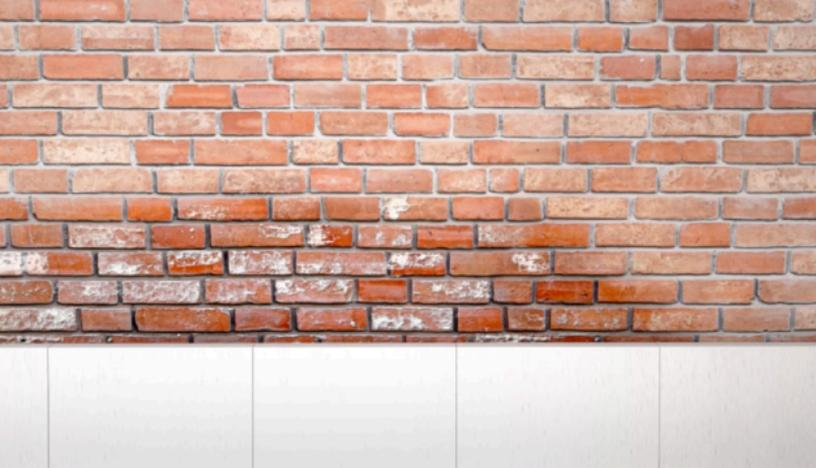
Erste Reihe waagrecht ausrichten. Stoß- und Lagerfugen werden nicht verklebt.
