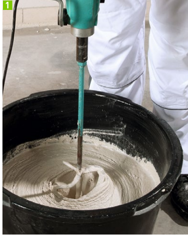
1 Multipor Leichtmörtel anmischen
