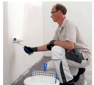
Auftragen der Multipor Innensilikatfarbe
