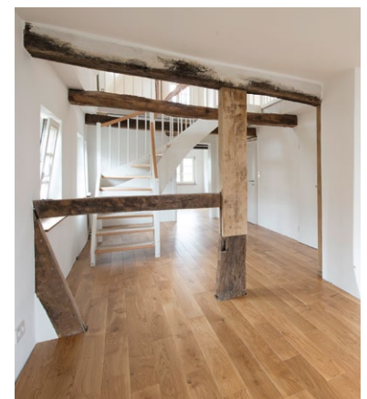
Hochwertiges Oberflächenfinish mit Multipor Lehmfarbe
