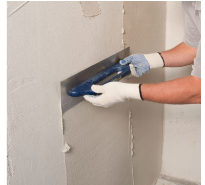
Aufziehen des Oberputzes
