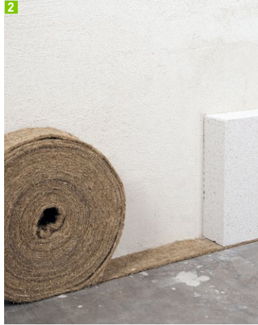
2 Mit Multipor Hanf-Filz-Dämmstreifen entkoppeln
