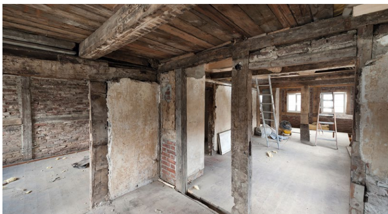
Komplette Kernsanierung mit dem Multipor Innendämmsystem WI Lehm
