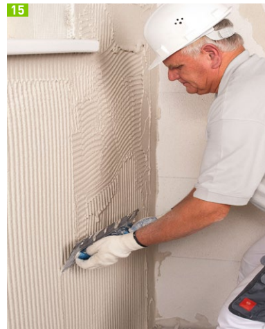
15 Armierungsschicht aufziehen
