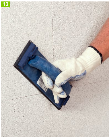
13 Unebenheiten beischiefen, Schleifstaub abfegen und eventuell grundieren
