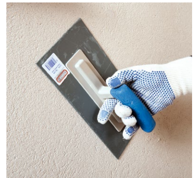
Strukturieren mittels Traufel
