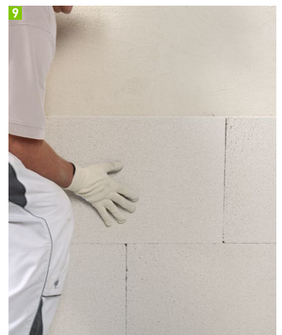
9 Stoß- und Lagerfuge dicht gestoßen
