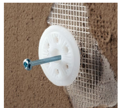
Setzen des Dübels durch das Gewebe
