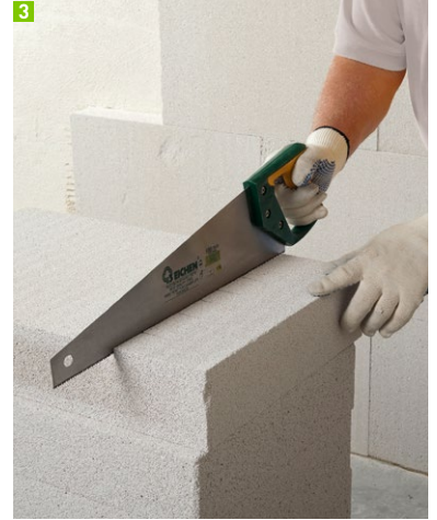
3 Multipor Mineraldämmplatte schneiden
