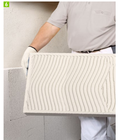
6 Mörtel vollflächig auf Mineraldämmplatte
