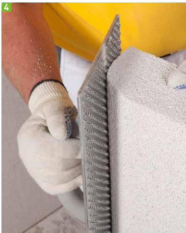
4 Anpassung der Dämmplatte
