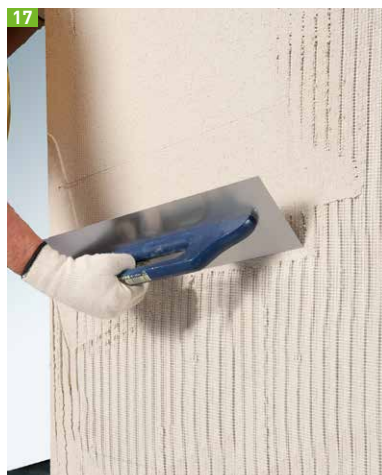
17 Armierungsgewebe einputzen
