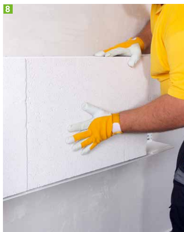
8 Multipor Mineraldämmplatte andrücken und einschwimmen
