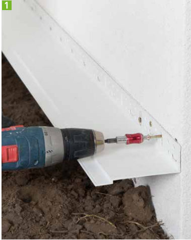
1 Kunststoffsockelschiene, gedübelt
