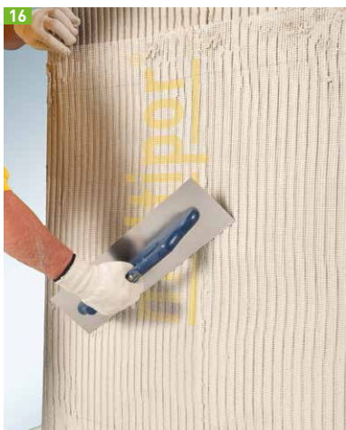
16 Armierungsgewebe einlegen
