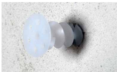
Setzen des Multipor Spiraldübel
