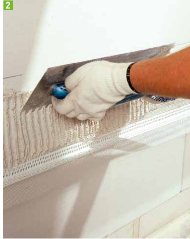
2 Sockelabschluss mit Gewebewinkel
