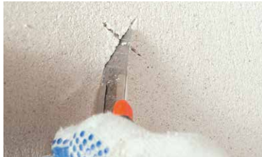
Vorsichtiges Einschlitzen der Putzschale
