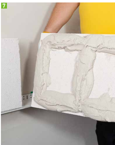
7 Randwulst-Punkt-Verklebung bei größeren Unebenheiten
