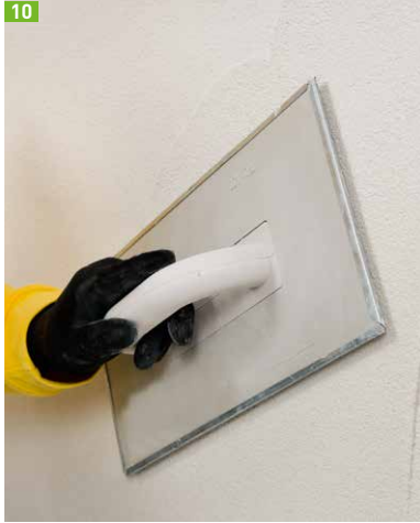
10 Beis Schleifen der Oberfläche
