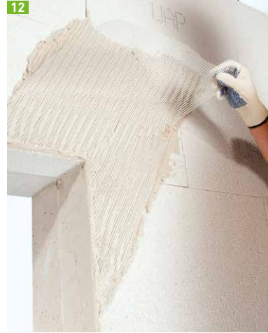
12 Armierungspfeile über Fensteröffnung
