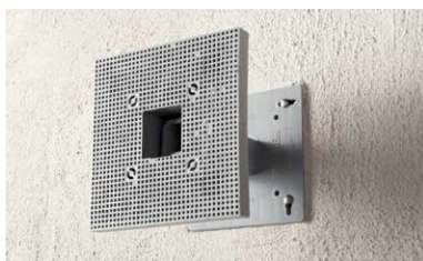
Einbau des Multipor Geräteträgers
