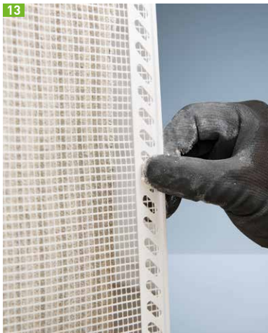
13 Gewebeeckprofil an Außenecke
