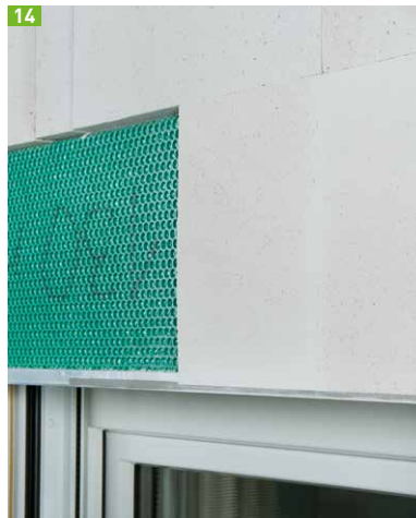
14 Überdämmung Raffstorekasten (mind. 60 mm)
