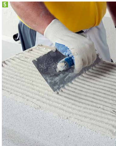
5 Multipor Leichtmörtel auf Dämmplatte auftragen
