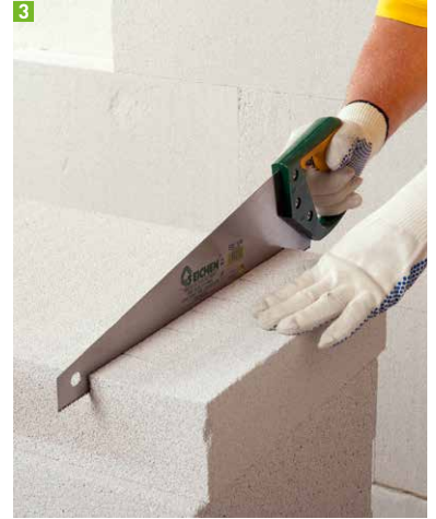
3 Schneiden der Mineraldämmplatte
