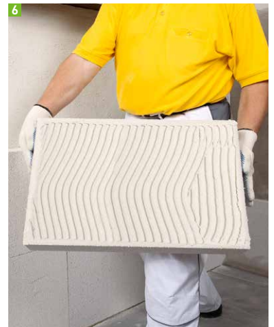
6 Vollflächig aufgetragener Mörtel
