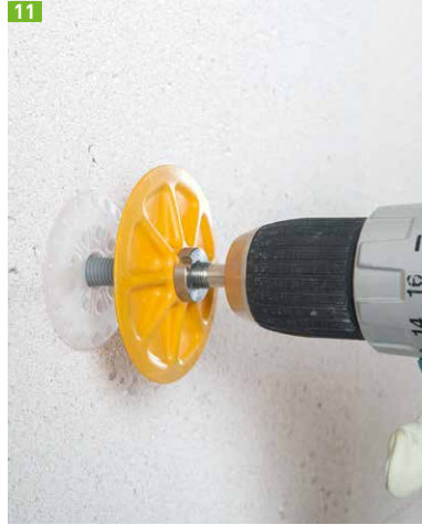
11 Dübel setzen
