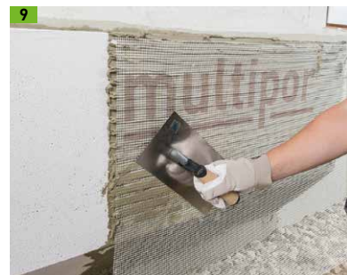
9 Multipor Armierungsgewebe auflegen und einputzen
