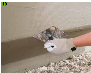
10 Armierungsschicht abziehen und 24 Stunden trocknen lassen
