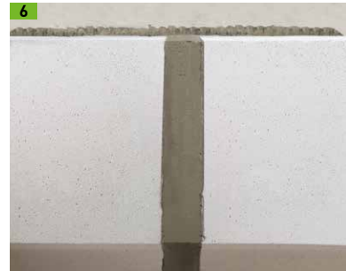
6 Dichtschlämme über die Fugen ziehen
