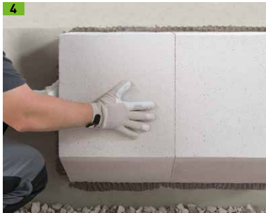
4 Multipor Sockeldämmplatte andrücken und einschwimmen
