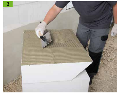
3 Multipor Dichtschlämme mit 12 mm-Zahntraufel vollflächig auftragen
