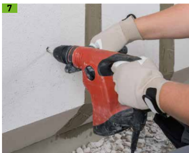
7 Multipor Schraubdübel setzen, Multipor Sockeldämmplatte fixieren und 24 Stunden trocknen lassen
