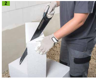
2 Multipor Sockeldämmplatte schräg zuschneiden
