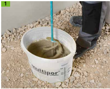
1 Multipor Dichtschlämme anmischen
