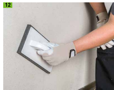
12 Oberputz filzen oder strukturieren
