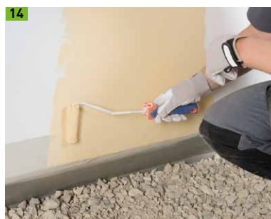
14 Sockel mit wasserabweisender Farbe anstreichen
