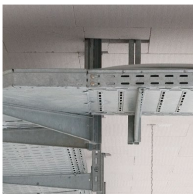
Befestigung eines Kabelträgers
