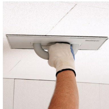
Einfaches Beischleifen
