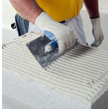
Mit mind. 12 mm Zahntaufel vollflächig auftragen und durchkämmen
