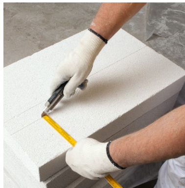
Platte ausklinken bei vorhandenen Leitungen
