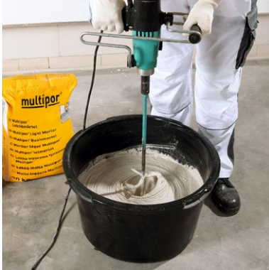
20 kg Leichtmörtel mit 8 l Wasser ergeben 30 l Klebmörtel.
