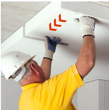
Multipor Mineraldämmplatte mit Leichtmörtel sofort im Abstand von ca. 2 cm zur vorherigen Platte an die Decke ansetzen und knirsch schieben (Fugen nicht mit verkleben!)
