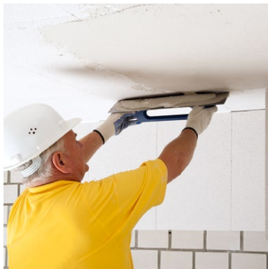
Multipor Leichtmörtel aufziehen
