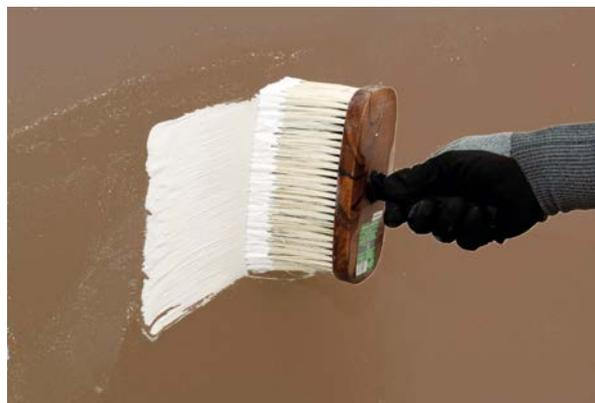
vollständige Farbdeckung sind zwei bis drei Arbeitsgänge erforderlich, wobei nach jedem Auftrag und bei normalen Umgebungsbedingungen etwa drei Stunden Trocknungszeit zu berechnen sind. Mit handelsüblichen mineralischen Abtönmaterialien bzw. Pigmentzugaben lässt sich jeder gewünschte Farbton für unsere Multipor Lehmfarbe erzielen.
