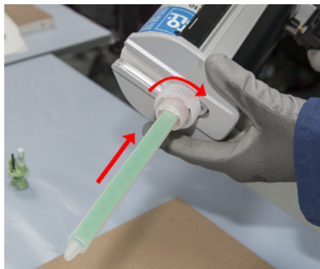
Statkmischer mit der Überwurfmutter fixieren
