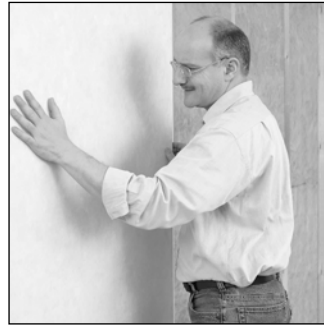
Einsetzen erste Platte
