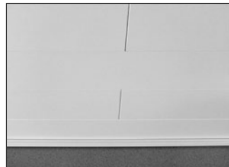
Deckenabschlussleisten aufstecken – fertig
