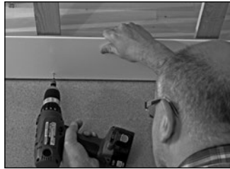
Erstes Steck-Paneel befestigen
