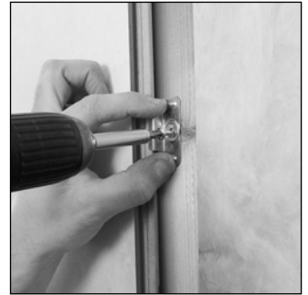
Mittelklammer setzen
