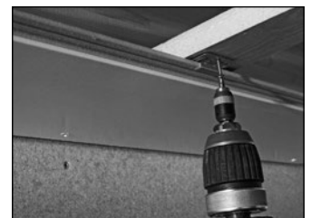
Befestigungskralle anschrauben
