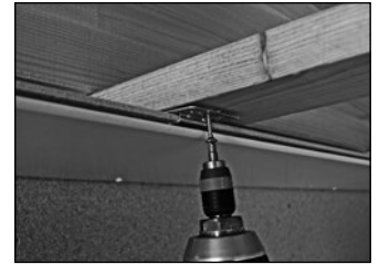
Befestigungskralle anschrauben
