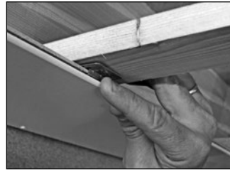
Befestigungskralle setzen
