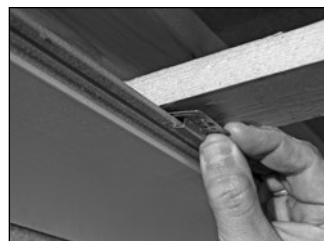
Befestigungskralle setzen
