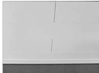
Deckenabschlussleisten aufstecken – fertig
