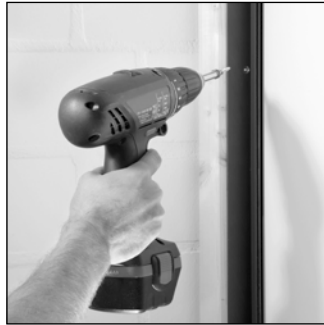
Befestigungsschiene setzen
