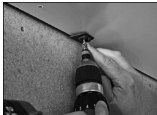
Leistencлип montieren
