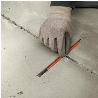
PCI Apogel® Dübel in den Einschnitt einlegen.
