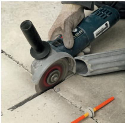
Den Estrich quer zu der sichernden Fuge im Abstand von ca. 30 bis 40 cm mit einem Trennschneider einschneiden.
