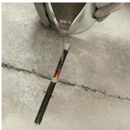
Oberflächenbündiges Verfüllen des Einschnitts mit dem darin liegenden PCI Apogel® Dübel mit PCI Apogel® F, abgemischt mit Quarzsand 0,3 bis 0,8 mm.
