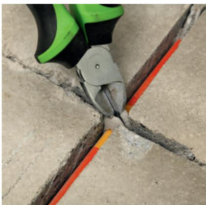
Den Kunststoffring, der den Expansionsschaum umschließt, mit einer Zange durchtrennen und entfernen.
