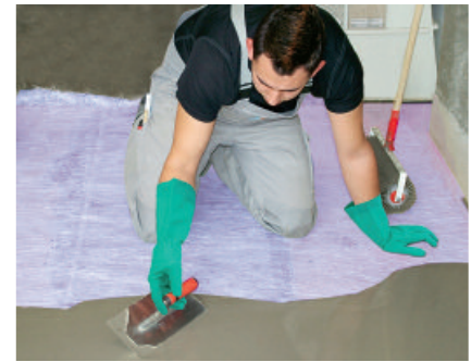
Die geeignete PCI Bodenausgleichsmasse wird auf der ausgelegten Glasfaserverstärkung PCI Armiermatte GFM ausgegossen und mit einer Spachtel verteilt (Mindestschichtdicke 5 mm).
