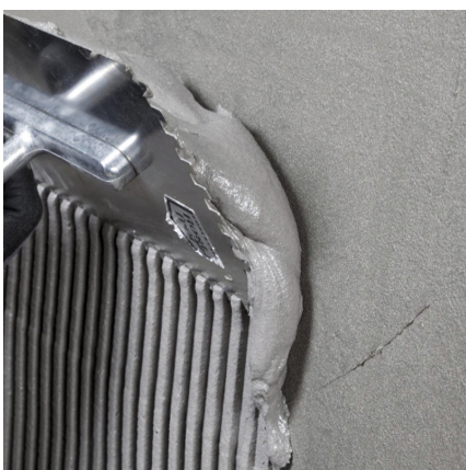
PCI Barraseal Turbo muss in mindestens 2 Abdichtungslagen aufgebracht werden. Zur Kontrolle der Schichtdicke kann das Material aufgezahnt und dann abgeglättet werden.
