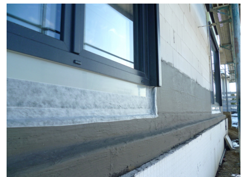
Anschluss eines bodentiefen Fensters im Übergang zur Sockelabdichtung mit PCI Barraseal Turbo.
