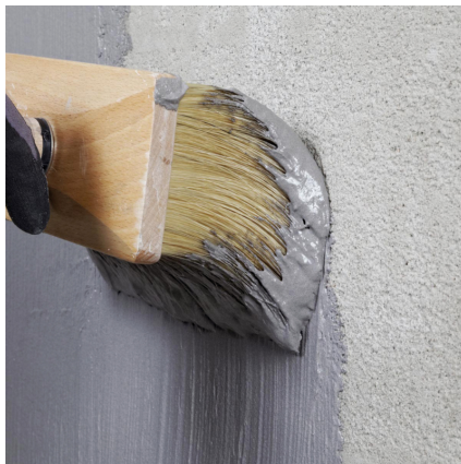
Aufbringen einer Kontaktschicht mittels Bürste oder Quast.
