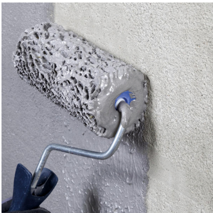
Aufbringen einer Kontaktschicht mit dem Roller.
