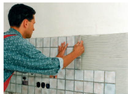
Die Fliesen rutschen nicht ab und können noch einige Zeit ausgerichtet werden.
